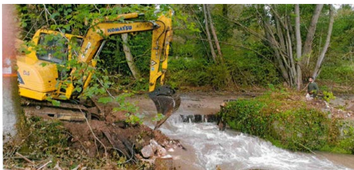
Evacuation des gravats démolis
