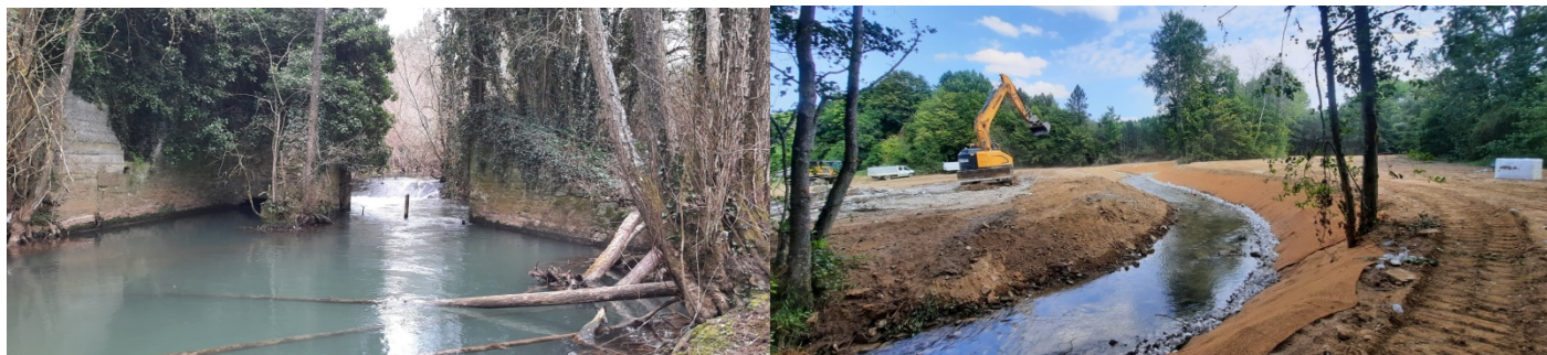
Avant : Etat initial, vannage de Bellefontaine après travaux
